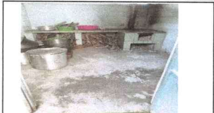
Foto 8: Sustrucción de piso de torta a azulejo
