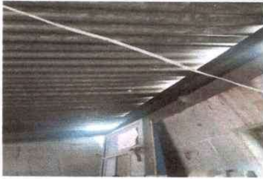
Foto 1: Sustitución de lamina
