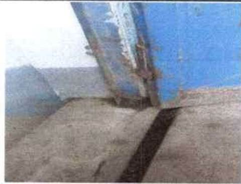
Foto 2: Mantenimiento a estructuras de puertas de metal
