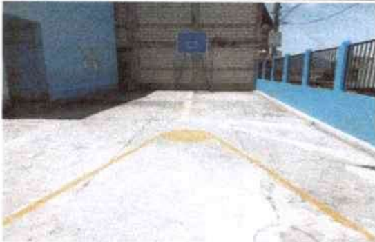
Foto 3: Sustitución de piso de torta de concreto
