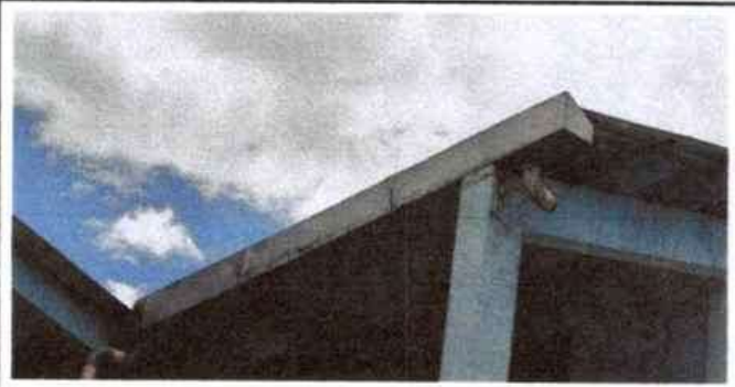
Foto 4: Sustitución de canal de metal en mal estado
