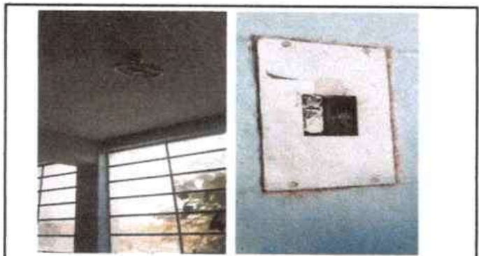
Foto 10: Reparación de sistema eléctrico
